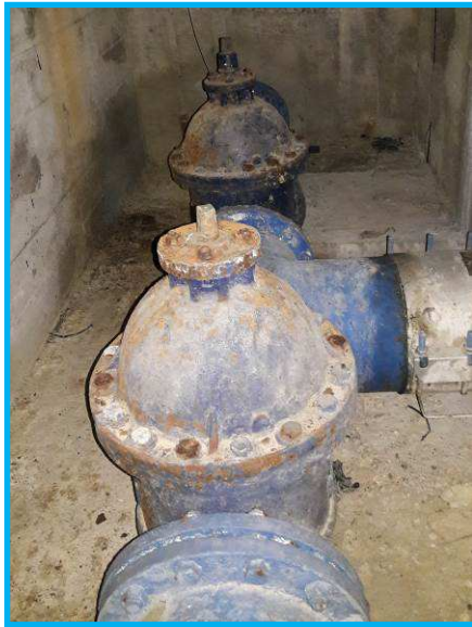
Castelnau-le-Lez – La Gardie : renouvellement vannes DN250mm réservoir La Gardie (avant / après travaux)
