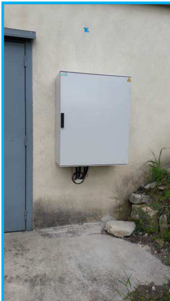
Coffret inverseur de Sources
