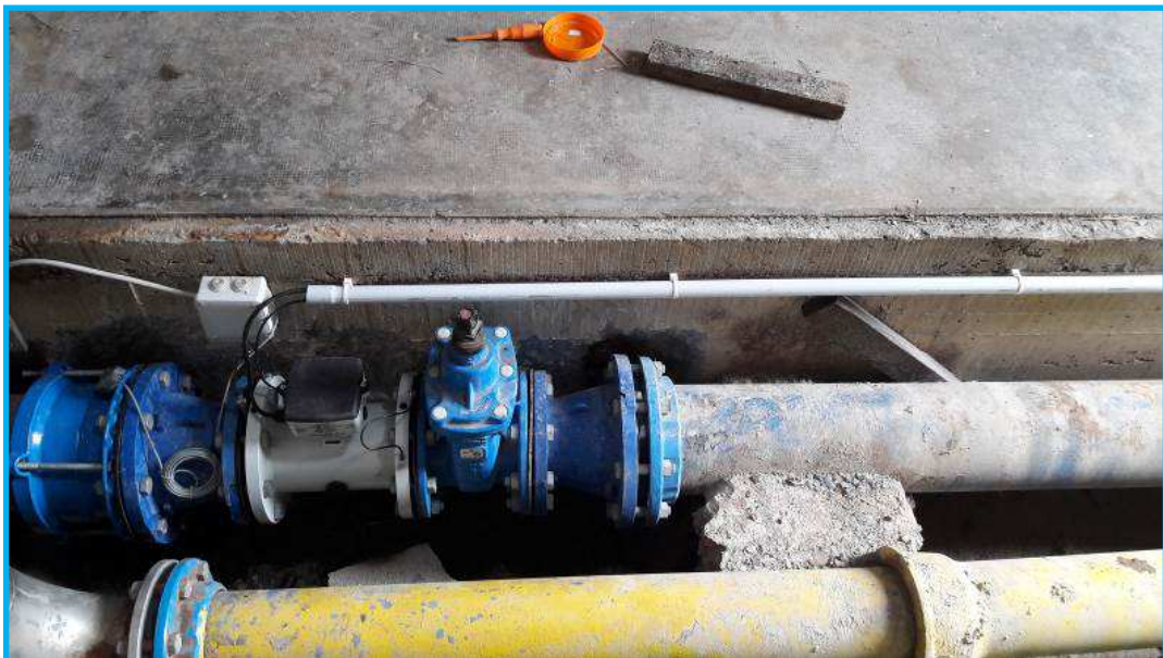
Réservoir de Beaulieu : Câblage afficheur et pose LS42
