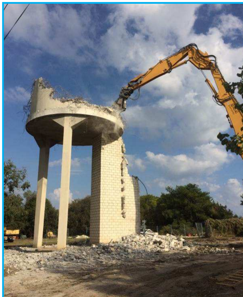
09 octobre 2018: Démolition du réservoir sur tour de Saussines
