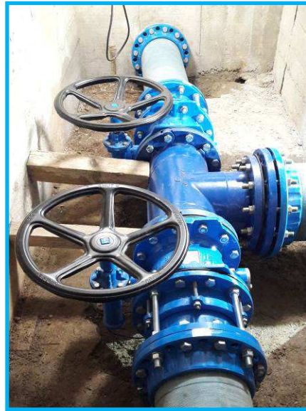
Castelnau-le-Lez – La Gardie : renouvellement vannes DN250mm réservoir La Gardie (avant / après travaux)
