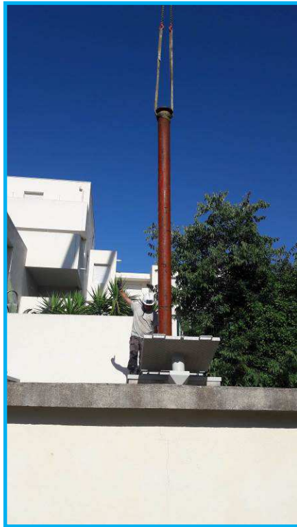
Castelnau-le-Lez – La Crouzette : pompe d'exhaure forage F3
